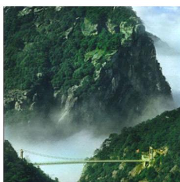
**【景点介绍】：**当地人又称铁索桥，座落在神龙宫地带，横跨于将军河面，悬空险秀，为庐山添一景。此桥，1993 年修。它的建成，既沟通他游览路线，又为提供观赏铁船峰和石门创造了最佳观景点，可谓一举两得。桥以四根铁管对应相参，再在上端并架铁索连接两岩高立钢盘水泥柱，斜拉组合吊力，加铺预制板面，牢固安全。登临桥上四顾神龙宫境。清幽雅然，铁船峰姿显示清晰，而传说中所讲帆船坠化巅峰上的轮廓历历映目，两峰并立有若门框之构成石门，溪流通过石门泻涧之声激昂悦耳，横生妙处。
